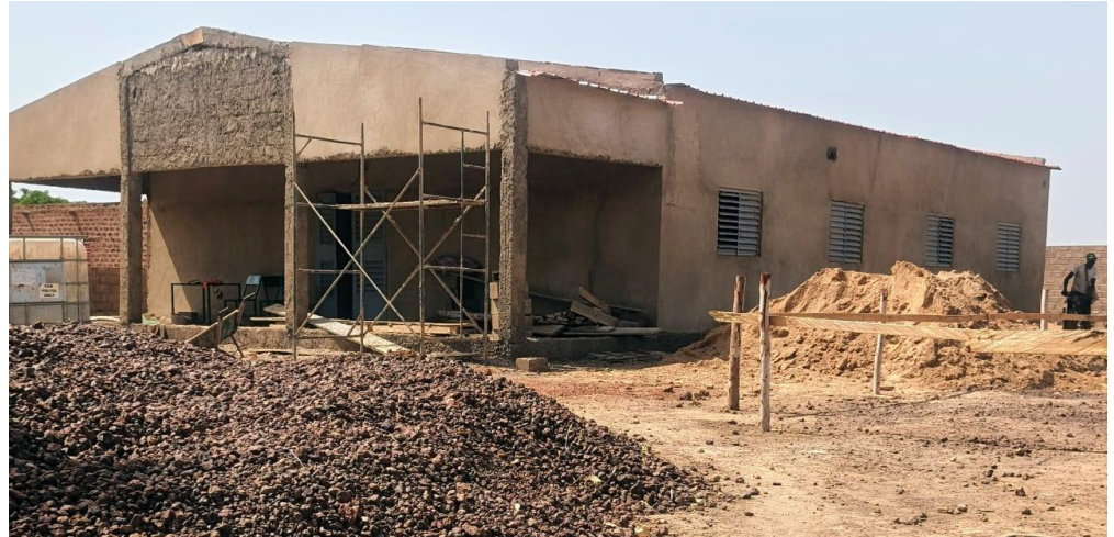
Abbildung 2: Der Rohbau des ersten Internatsgebäudes für 20 Kinder, finanziert durch die Stiftung Fly & Help
