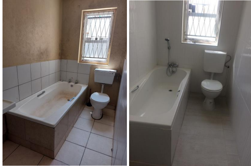
Badezimmerrenovierung – Vorher und Nachher
