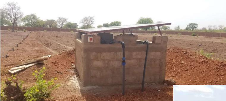
Abbildung 2 Wasserbecken als Zwischenspeicher für die Bewässerung mit Solaranlage für den Pumpenbetrieb
