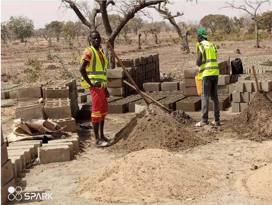
Abbildung 1 Arbeiten fertigen Zementsteine
