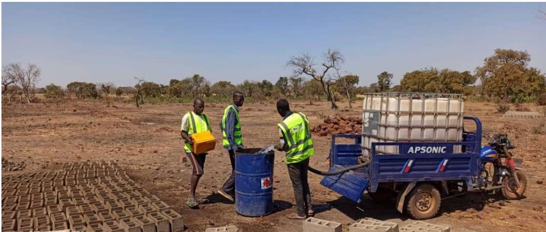
Abbildung 2 Die Zementsteine werden gegossen
