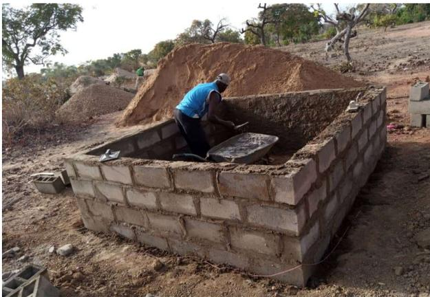
Abbildung Aufbau des Wasserreservoirs
