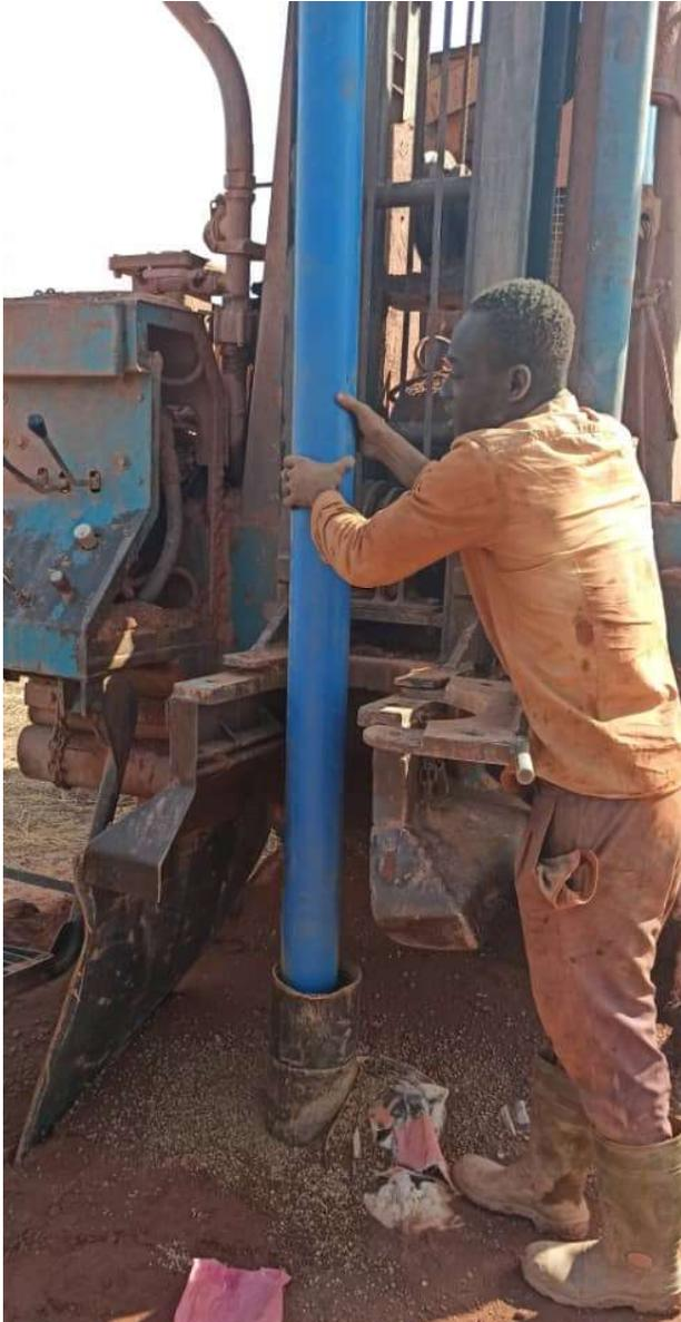
Gleich nach einer ersten Untersuchung stellte die Bohr-Firma fest, dass die Wahrscheinlichkeit für eine positive Bohrung sehr groß ist. Unverzüglich fingen sie mit der Bohrung an, trafen auf Wasser und erreichten ein Fördervolumen von bis zu 20 m<sup>3</sup>/h. Knapp dreimal so hoch, wie bei unserer ersten Bohrung am Sitz der Frauenkooperative in Dedougou.
