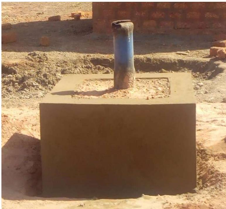
Dann wurden die Rohre zum Wasser einzementiert und alles vorbereitet, damit die Pumpe beim nächsten Termin montiert werden konnte.
