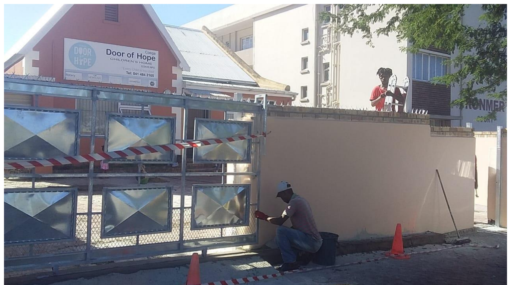
Das neue Tor wird in die Grundstücksmauer eingepasst
