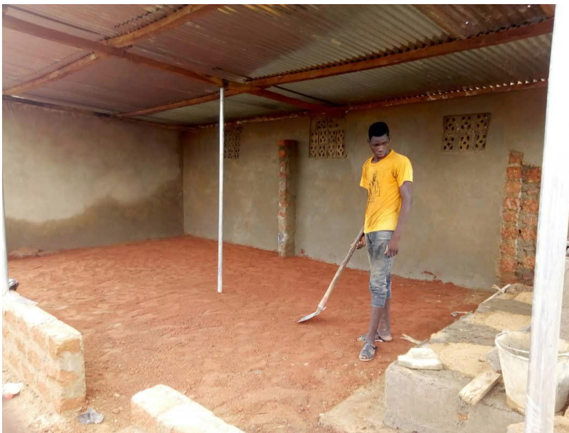
Abbildung 2: Das Vordach und die Terrasse werden fertiggestellt
