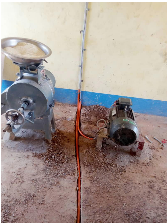
Abbildung 4.1: Dann wurde der Boden wieder in Ordnung gebracht und zementiert.
