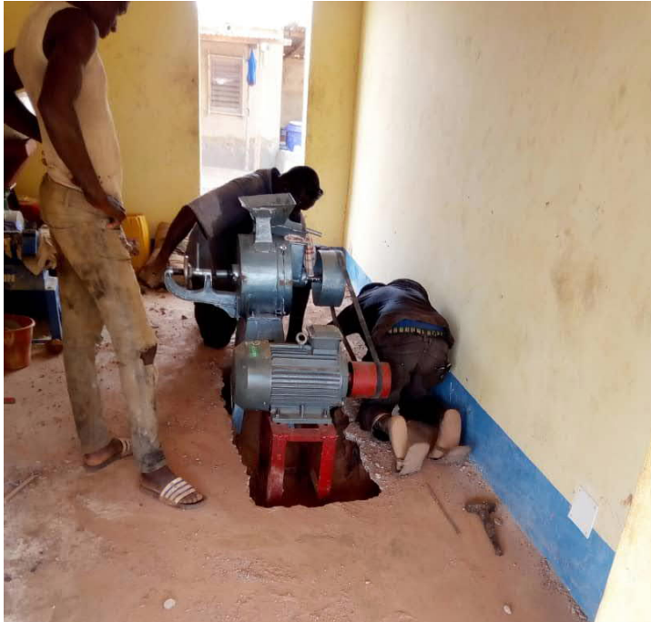
Abbildung 4: Ein Loch wurde gegraben, um die Mühle tief in den Boden zu zementieren. Auch der neue Antrieb-Motor wurde fixiert und die notwendigen Kabeln vom Elektriker verlegt.
