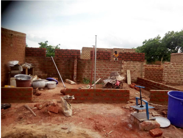
Abbildung 1: Der Rohbau für die Kochplätze.
