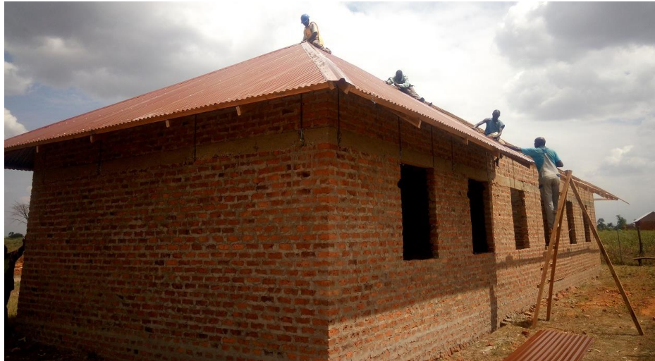
Arbeiten am Neubau
