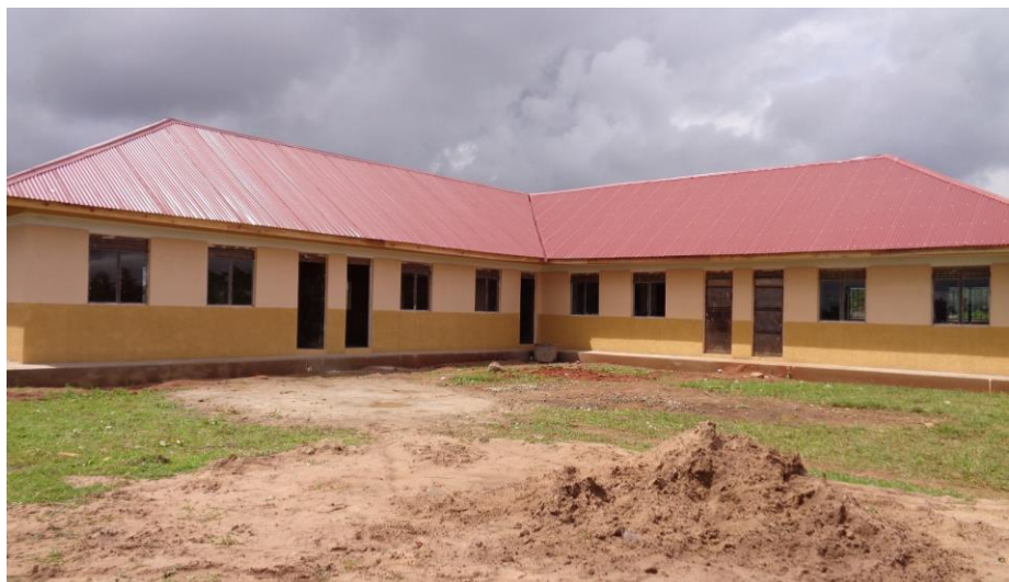
Neubau für Schlafräume
