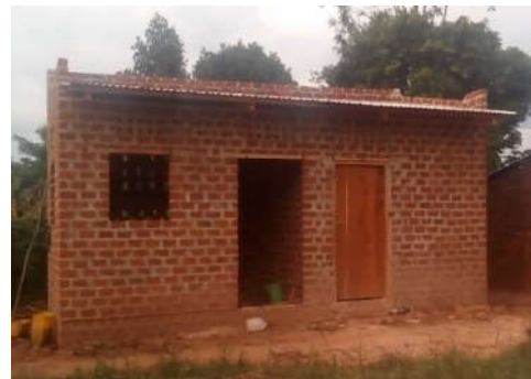
Küche mit Lagerraum
