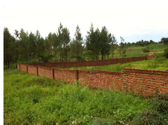
Auch die Mauer, eine behördliche Auflage, konnte fertiggestellt werden!
