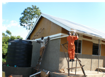
Die Sky Standard N&P School in Kalagi hat ein 2. Schulgebäude bekommen..
